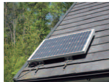
50Wソーラーパネル設置
